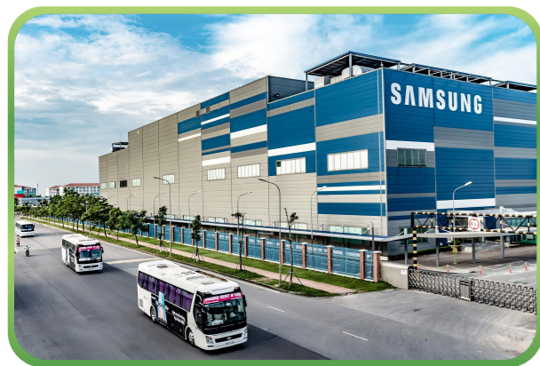
Hệ thống nhà máy Samsung KCN Yên Phong - Tỉnh Bắc Ninh. >>> Hơn 300 bộ cửa tự động SWICO.
