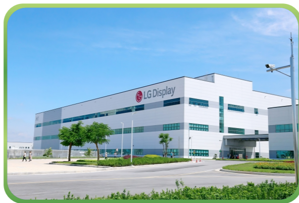
Hệ thống nhà máy LG KCN Tràng Duệ - Hải Phòng. >>> Hơn 50 bộ cửa tự động SWICO.
